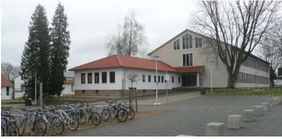
Vorne Gebäude 1, Zugang zum Gebäude 3 rechts dahinter
